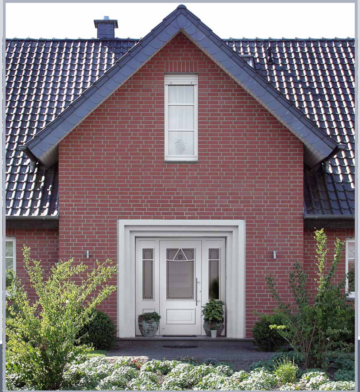
S 1112 außen aufgesetzt
