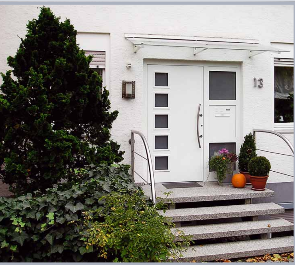
S 1021 außen aufgesetzt
