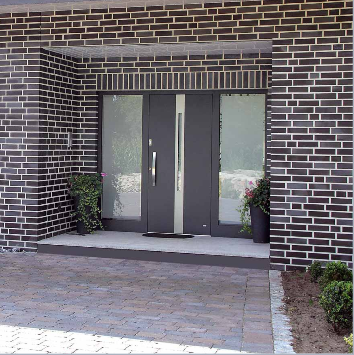
S 3070 außen aufgesetzt
