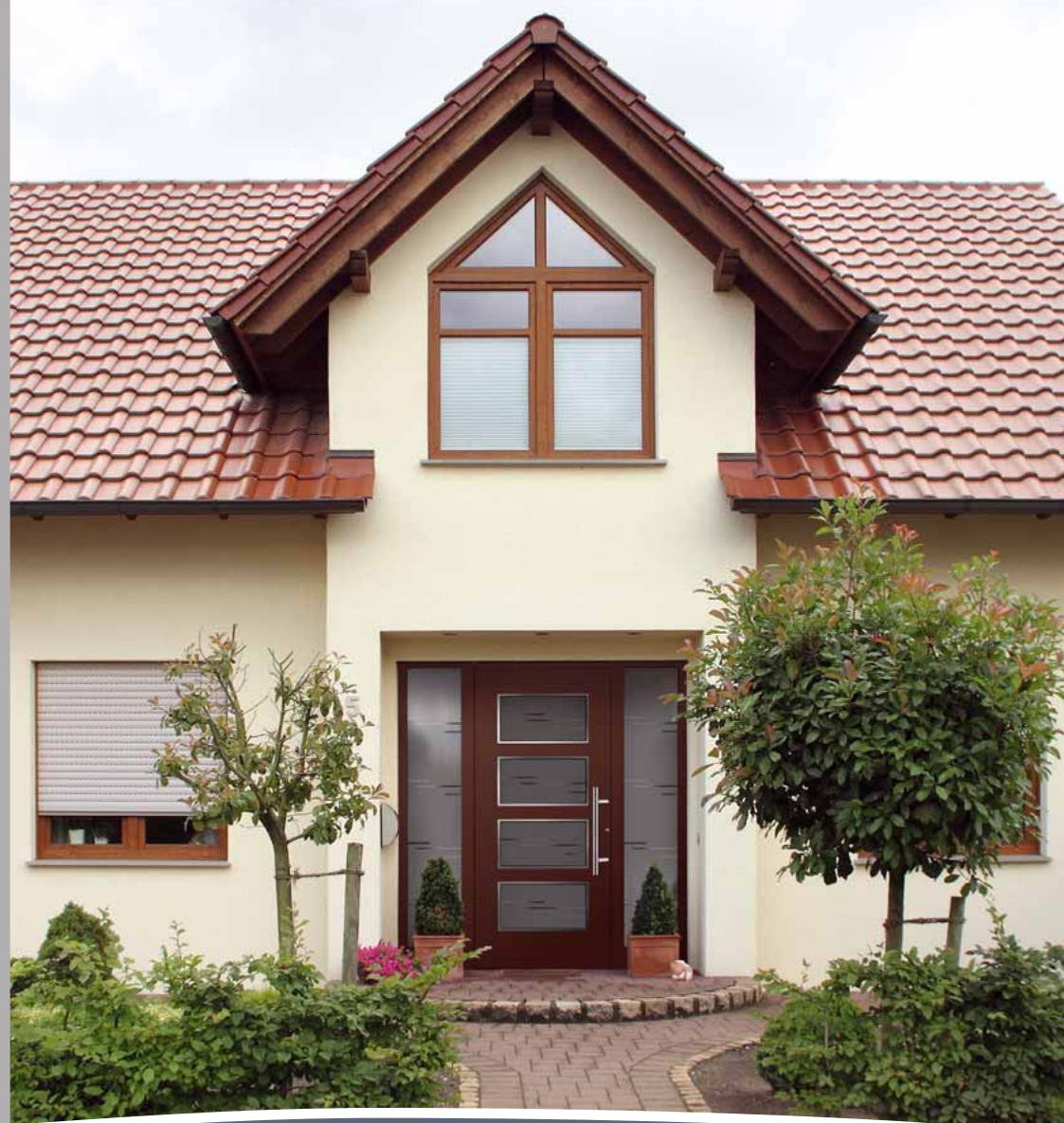
S 3081 außen aufgesetzt
