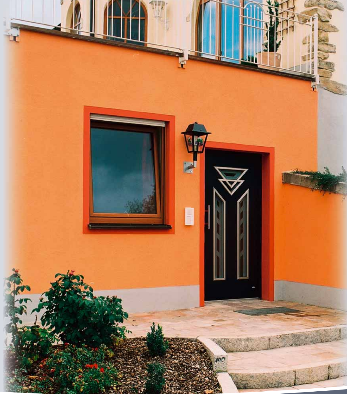
S 1725 außen aufgesetzt
