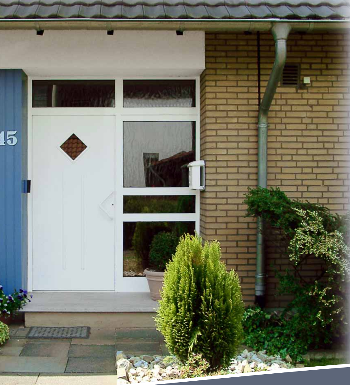
S 1310 außen aufgesetzt
