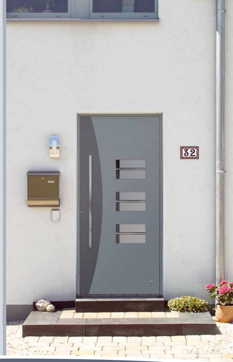
S 3069 außen aufgesetzt
