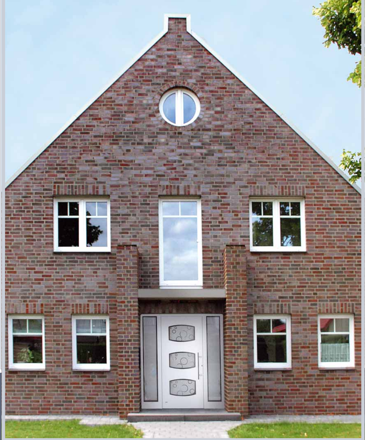
S 3021 außen aufgesetzt
