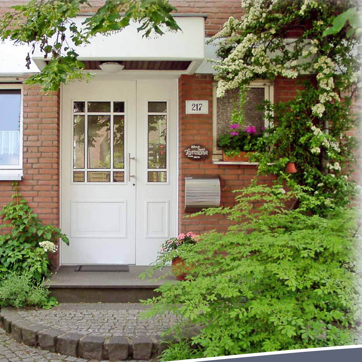
S 1115 außen aufgesetzt
