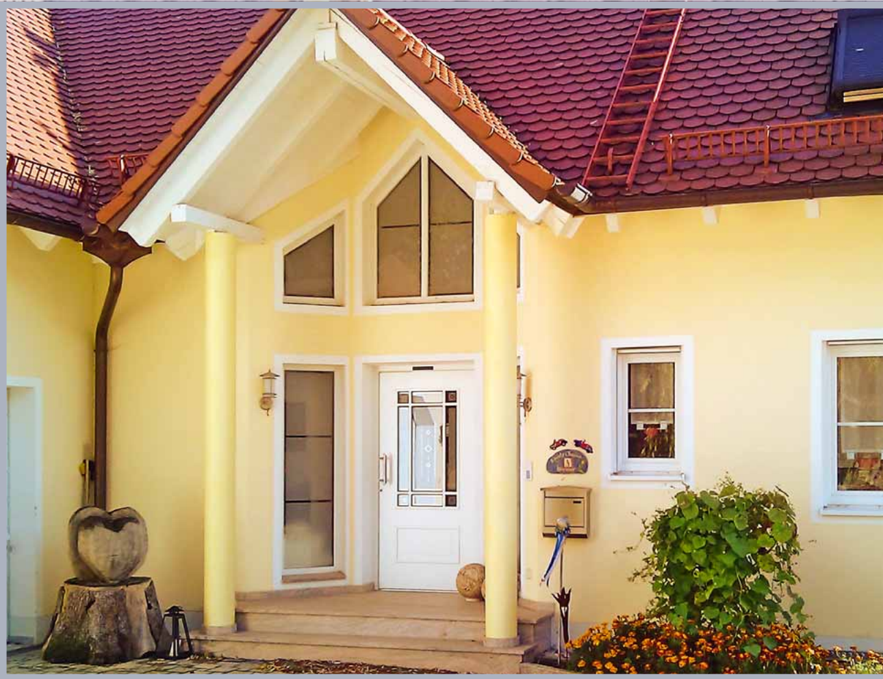
S 1117 außen aufgesetzt
